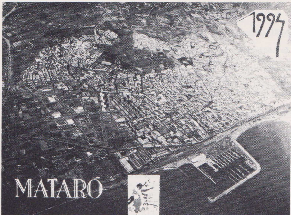
VISTA AEREA DE LA CIUDAD DE MATARÓ
