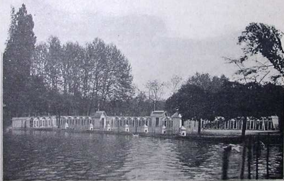
VISTA PARCIAL DE LA INSTALACIÓN
