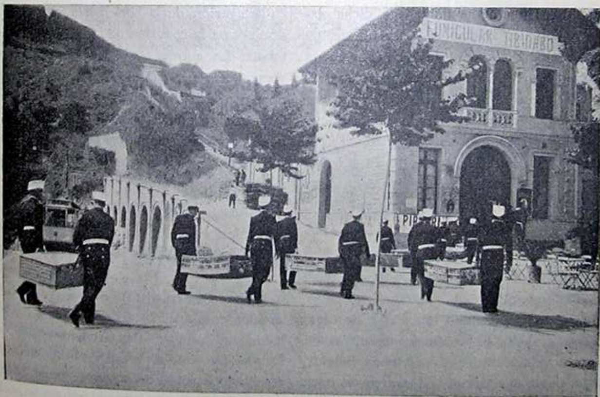
Conducción de las cestas por soldados de Ingenieros desde el tren eléctrico al ferrocarril funicular
