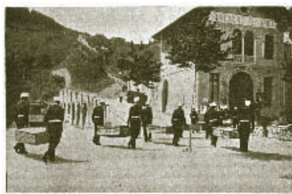
Conducción de las cestas por los soldados de ingenieros desde el tren eléctrico al funicular
